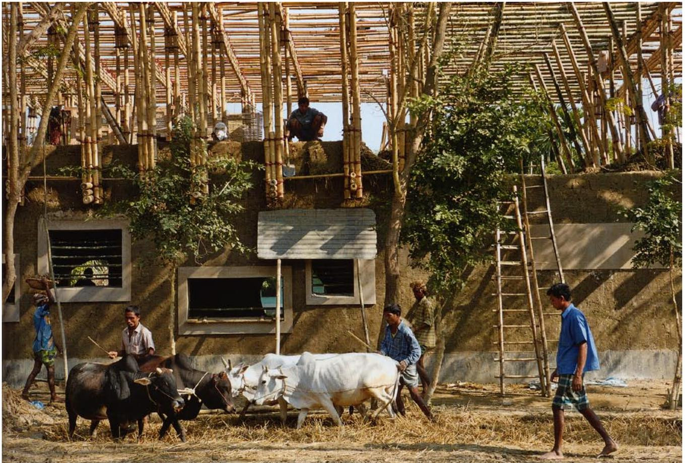
Beschneiden der Wand kann mit dem Wellern (Aufschichten) des zweiten Satzes begonnen werden. In den dritten und vierten Satz der Wand wurden Tür- und Fensterstützen sowie ein Ringbalken aus Bambusstäben als Übergang zur Decke eingebaut.“ Die Deckenkonstruktion besteht aus Bambus. Leicht und offen präsentiert sich das Obergeschoß, basierend auf einem Rahmentragwerk aus einem vierlagigen Bambusträger sowie vertikalen und diagonalen Stützenpaaren.
